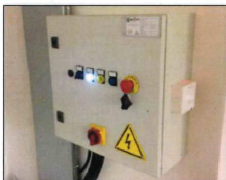
FASE 3) Armare il quadro posizionando l'interruttore generale su "I", verificare che la luce blu sia spenta, se così non fosse provvedere a disarmare il fungo emergenza sul quadro e/o sulla pulsantiera. Ora verificare che la luce blu sia spenta.
