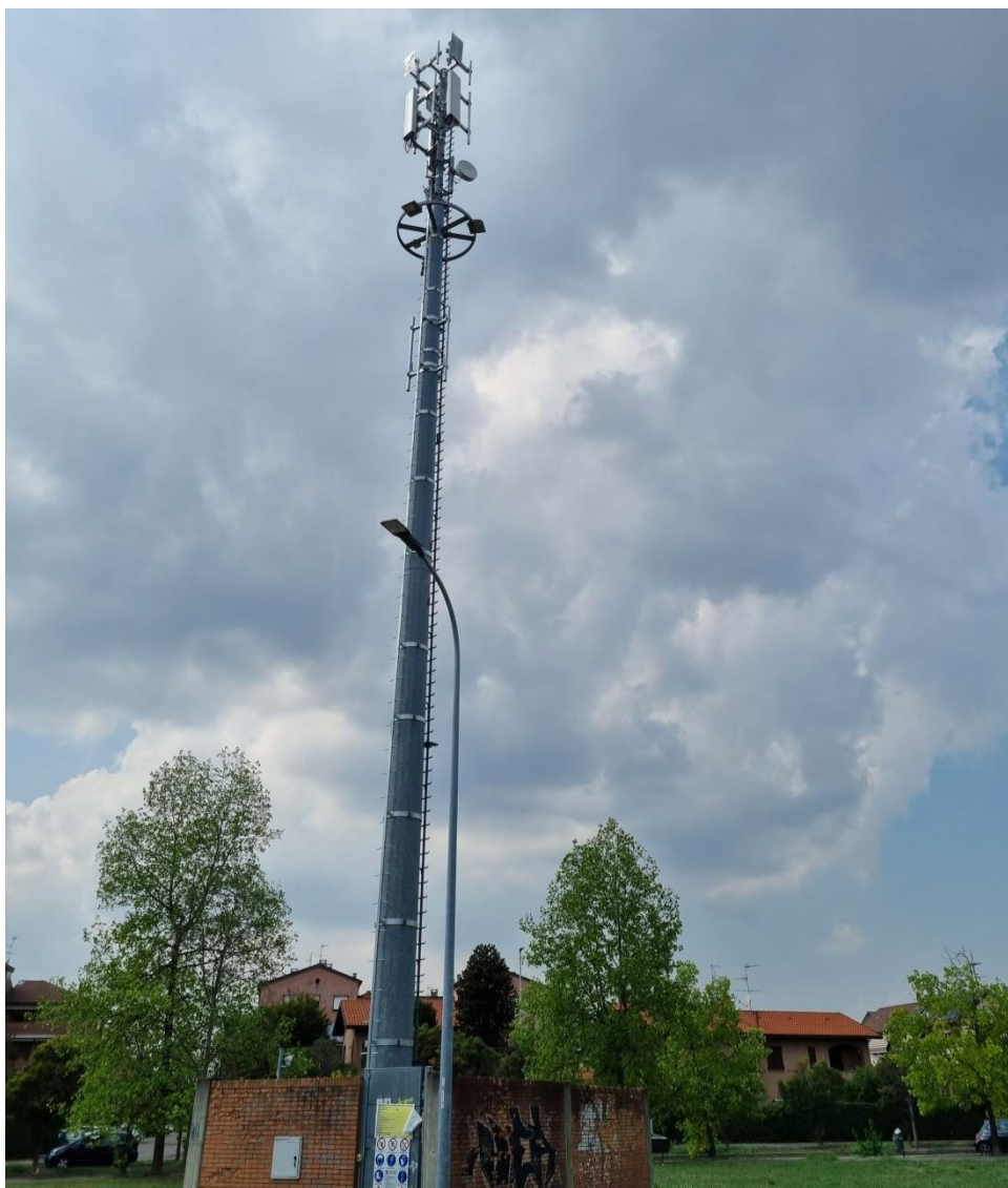
Impianto presente nell'areale del sito oggetto di variante.
