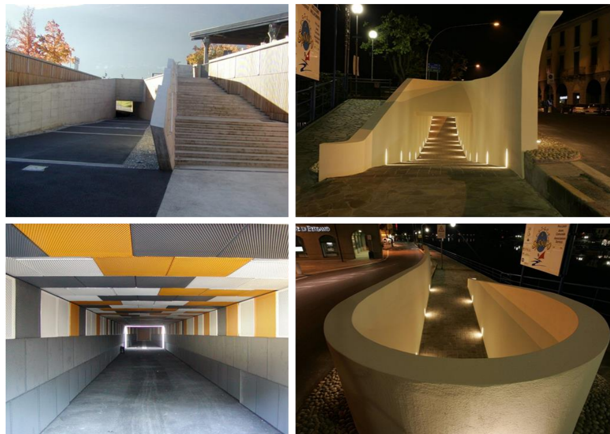
Figura 42: rampe di ingresso a sottopassi pedonali e ciclabili. a sinistra, sottopasso della stazione di Sondrio; a destra sottopasso a Sarnico (BG).
